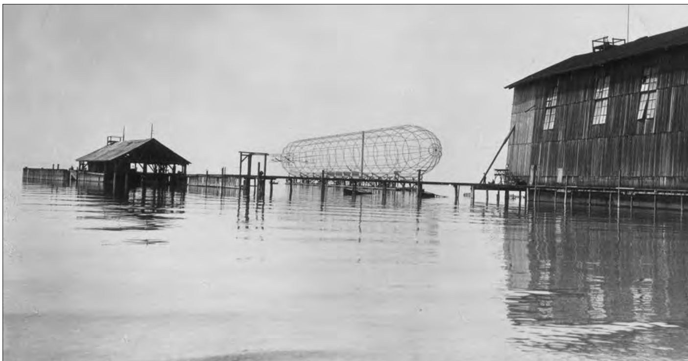
Foto oben: Das Gerippe des LZ 6 wird von der festen Halle in die schwimmende Halle in der Manzeller Bucht transportiert, 1909. © Zeppelin Museum Friedrichshafen
