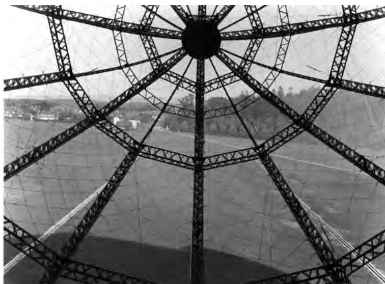
Lotte Eckener: LZ 129 Hindenburg im Bau, ca. 1935 © Zeppelin Museum Friedrichshafen
